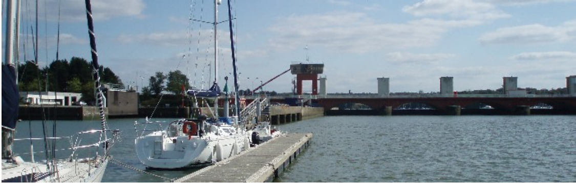
L'écluse en travaux
