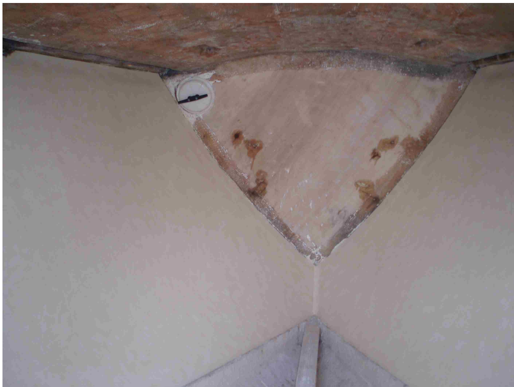
Le nouveau vaigrage à poste
