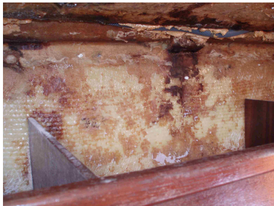
Coffre supérieure sur bâbord avant grattage
