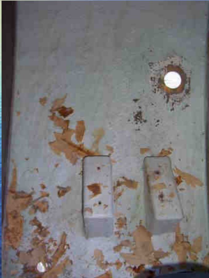
Démontage des vannes
