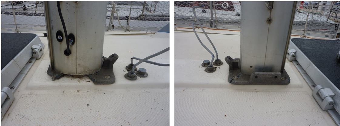
Etat des lieux avant démontage
