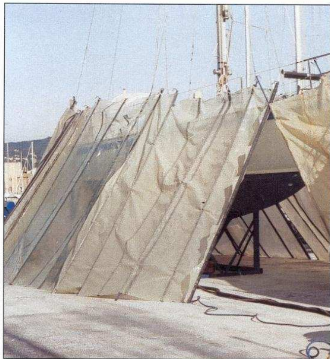
Photo 2-2 : protection pour ne pas faire voler le sable
