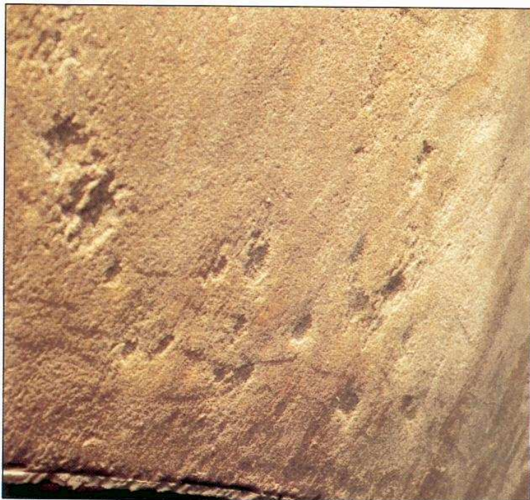
Photo 2-24 : cratères après sablage
