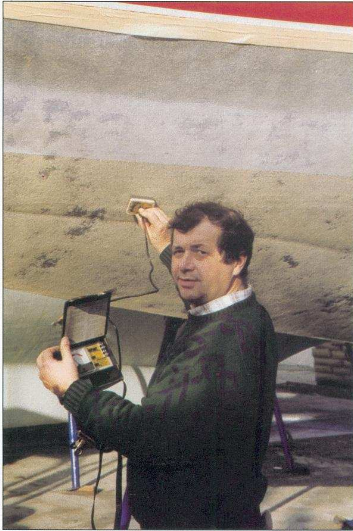
Photo 2-12 : mesure d'humidité du stratifié avec un " SOVEREIGN Moisture Master "
