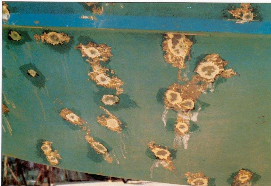
Photo 2-14 : traitement localisé aux cloques seules. Il faudra recommencer dans peu de temps
