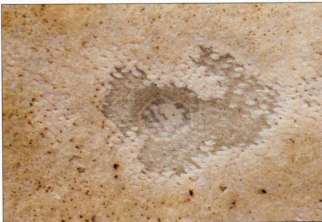
Photo 2-32 : dégradation des premiers mats, du roving suivant, des mats suivants et enfin du 2ème roving. Profondeur du cratère : 9 mm
